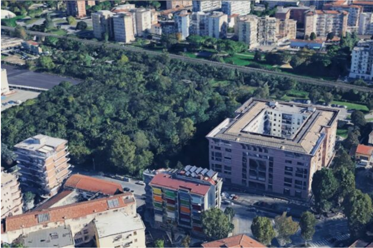
Bosco urbano di Novoli prima dell'abbattimento
