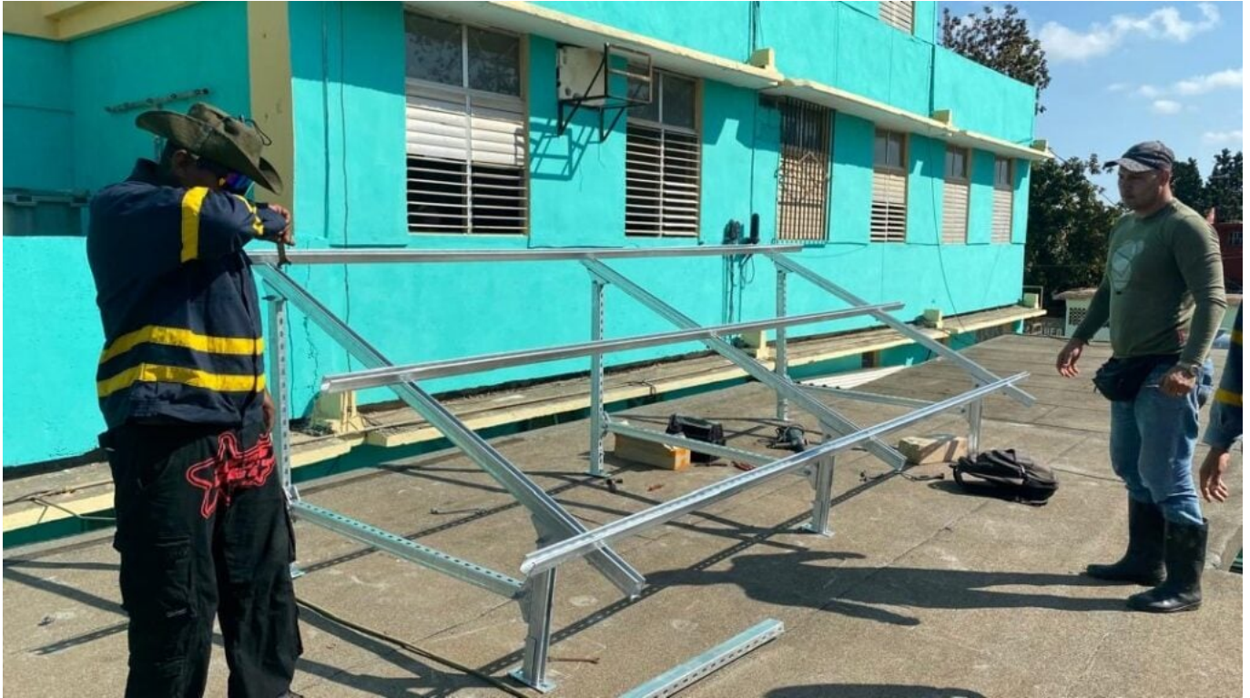
Installazione di un sistema fotovoltaico al "Policlinico Pablo Noriega de Quivicán".
