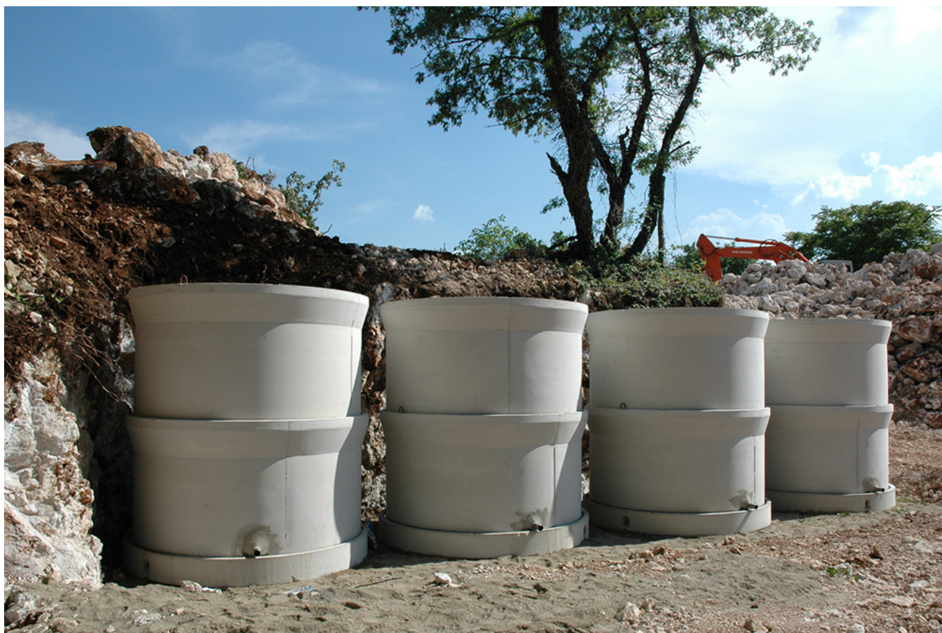
Serbatoi di raccoglimento d'acqua piovana
