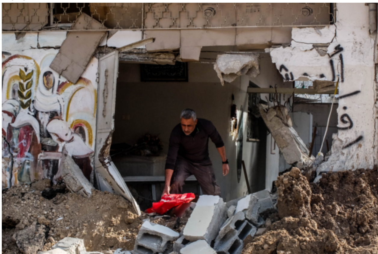
Uomo che ripara la sua casa danneggiata nel raid, 26 dicembre 2024
