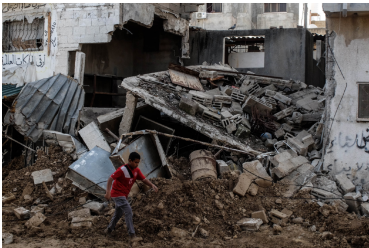
Casa demolita dalle bombe israeliane, Tulkarem Refugee Camp [foto di Moira Amargi]
