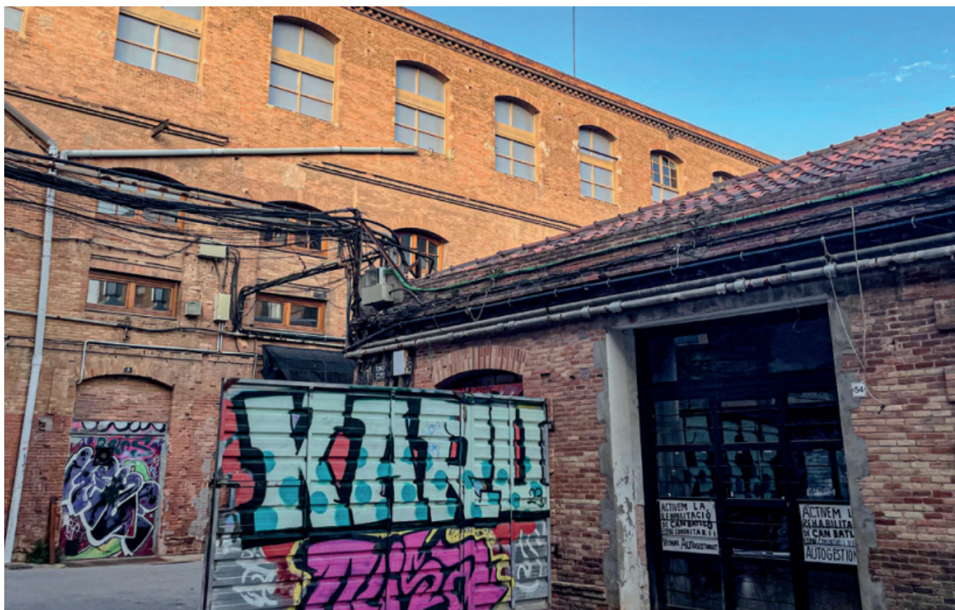
Scorcio tra due blocchi del polo industriale di Can Batllò
