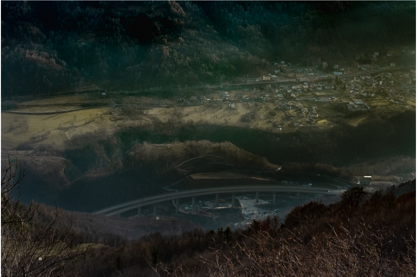
Il tratto della A32 sotto la quale si trova il cantiere della linea Torino-Lione
